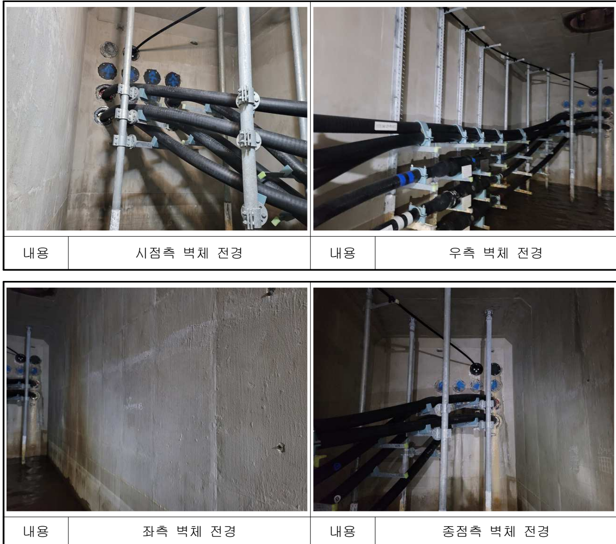
【사진 4.17】 남면~백석#3 전경
