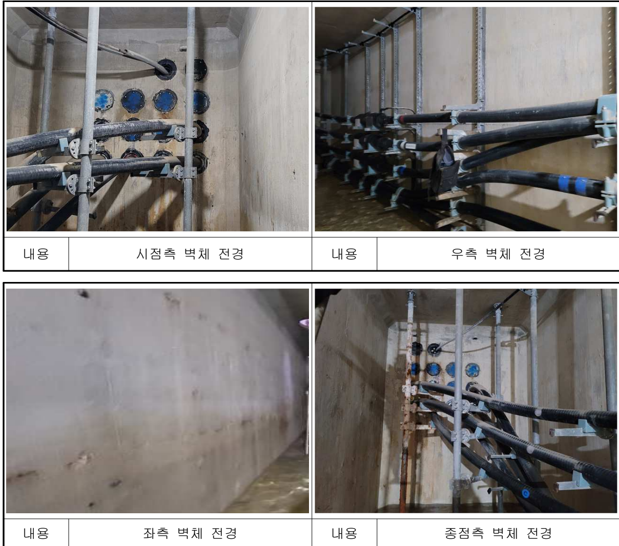
【사진 4.49】 남면~백석#11 전경
