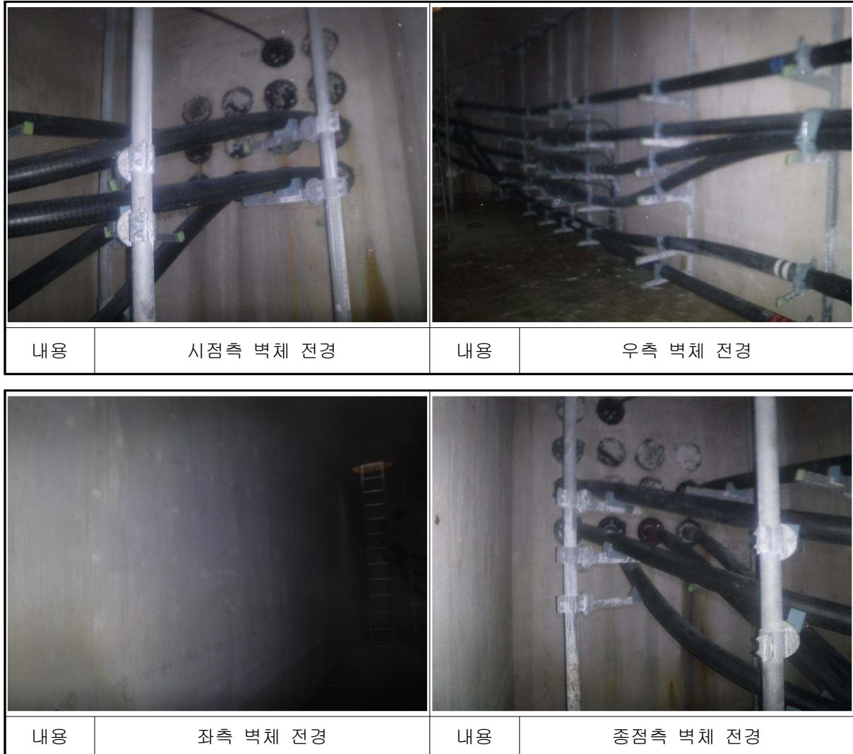
【사진 4.61】 남면~백석#14 전경
