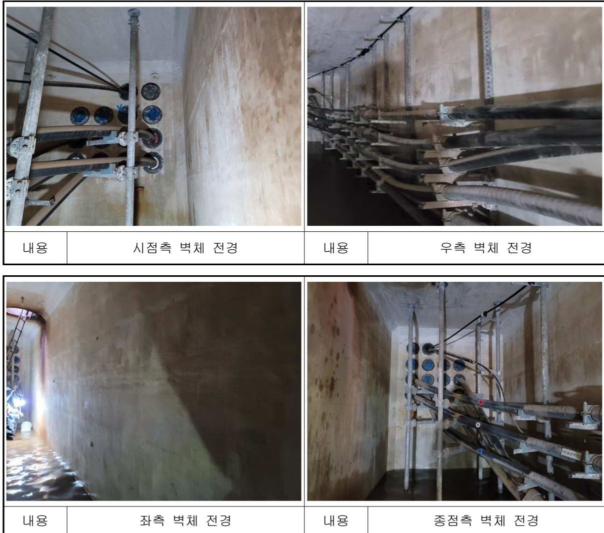
【사진 4.45】 남면~백석#10 전경
