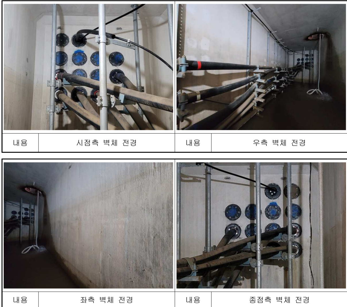
【사진 4.41】 남면~백석#9 전경
