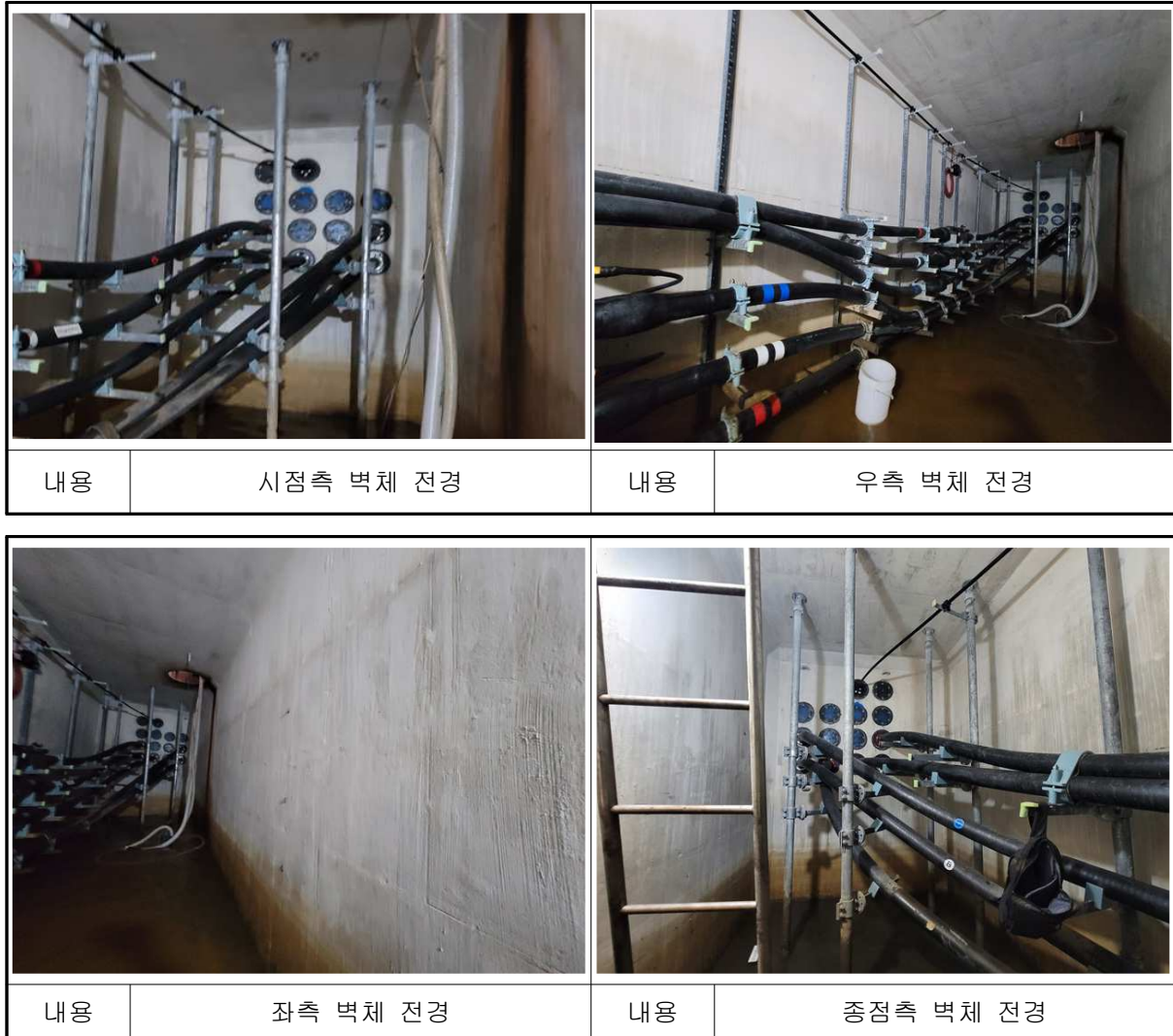
【사진 4.37】 남면~백석#8 전경
