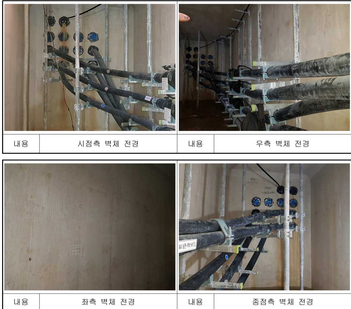
【사진 4.65】 남면~백석#15 전경
