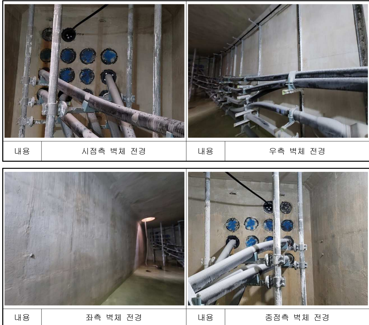
【사진 4.53】 남면~백석#12 전경
