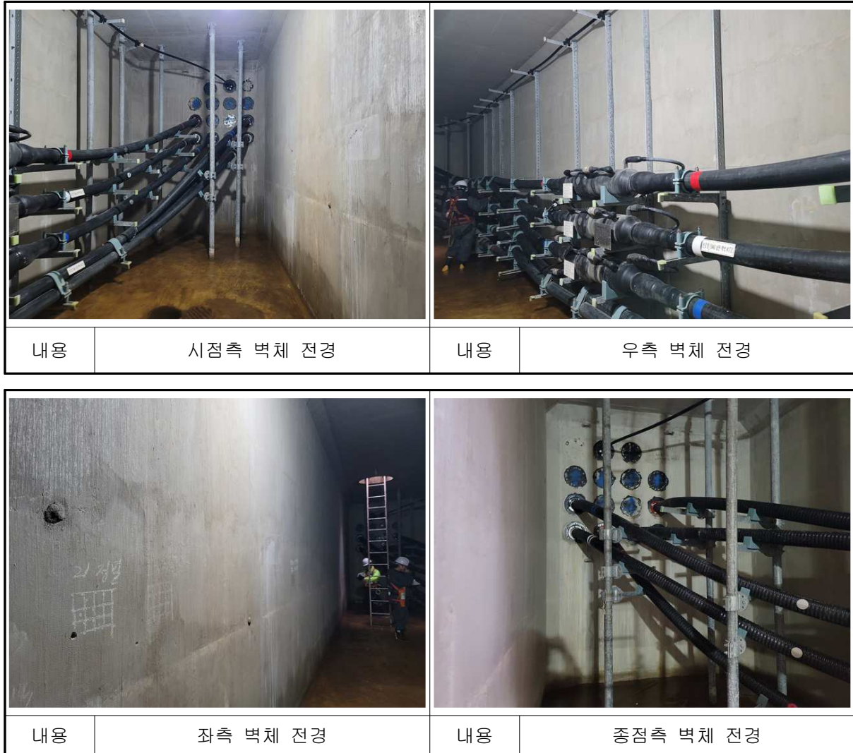
【사진 4.9】 남면~백석#1 전경
