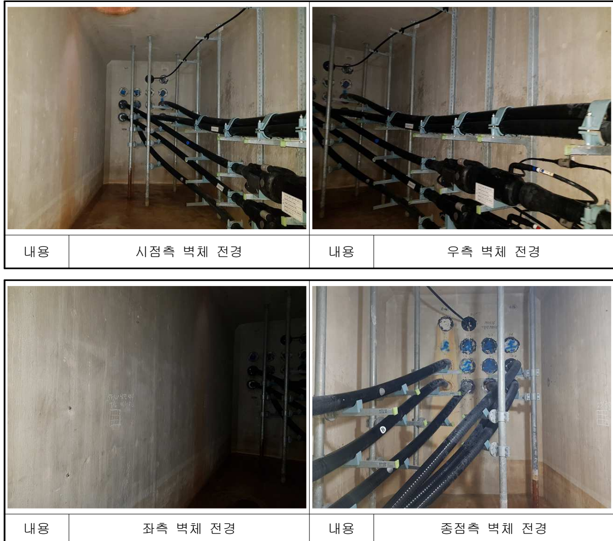
【사진 4.69】 남면~백석#16 전경
