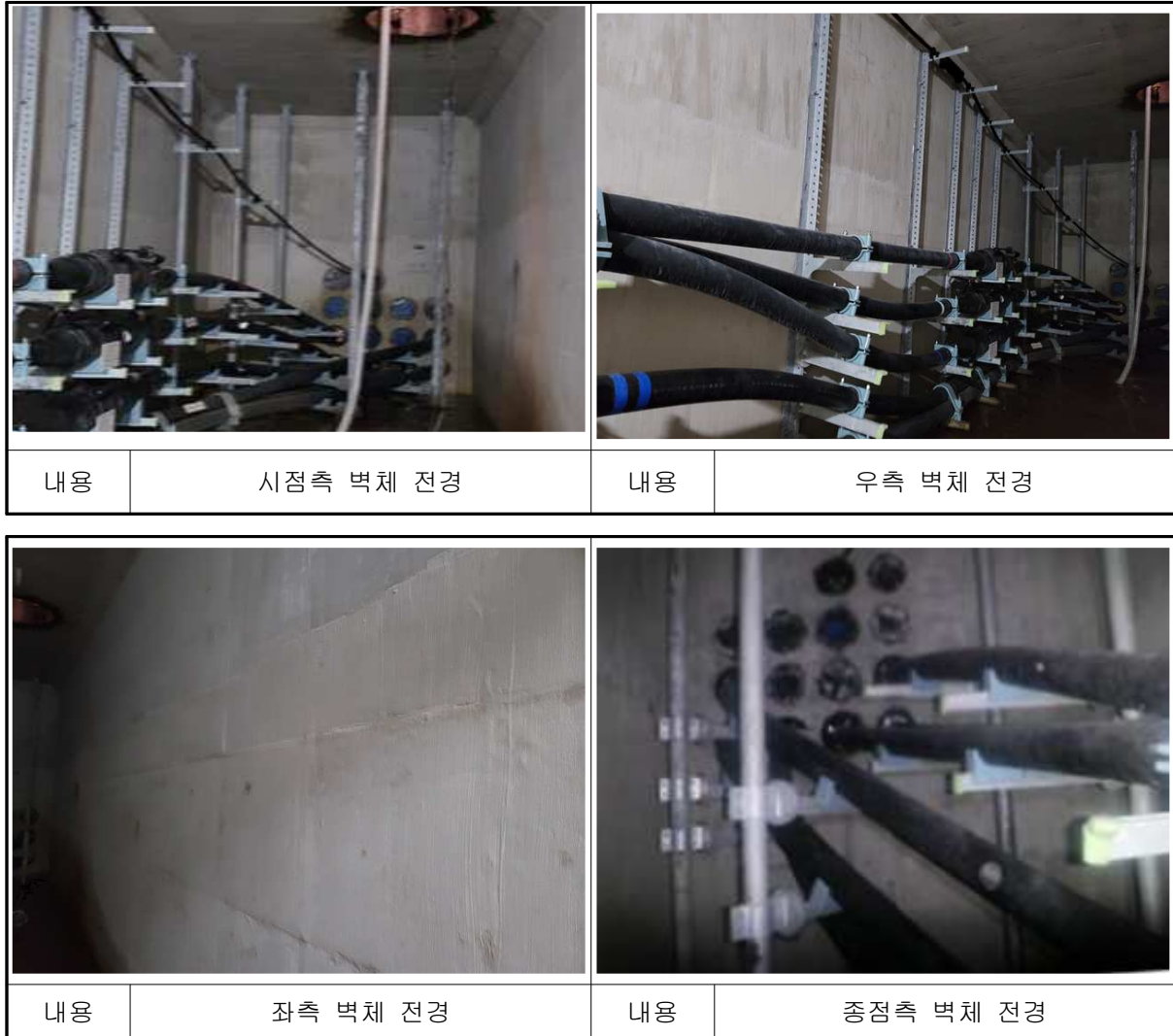
【사진 4.25】 남면~백석#5 전경
