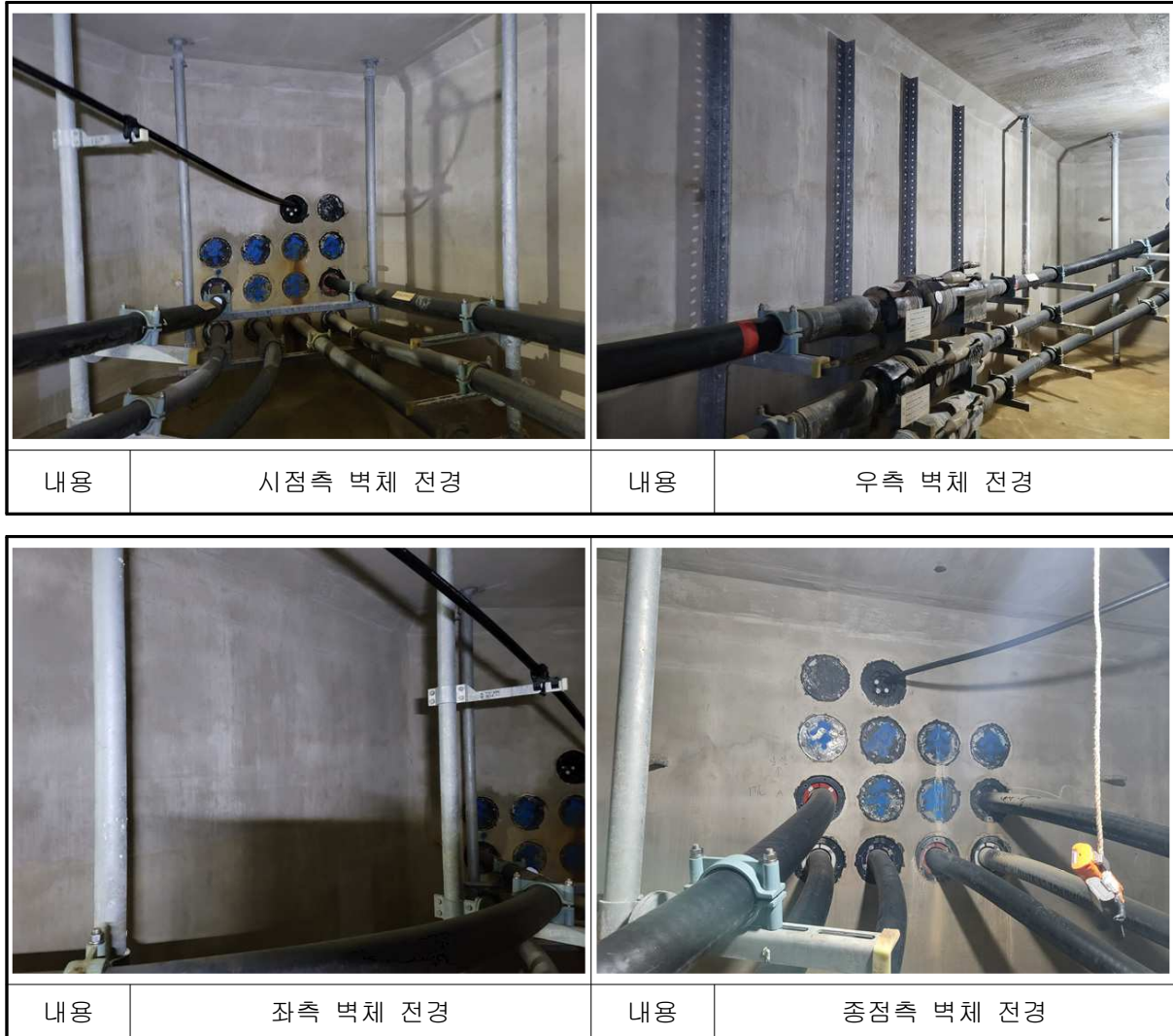
【사진 4.21】 남면~백석#4 전경
